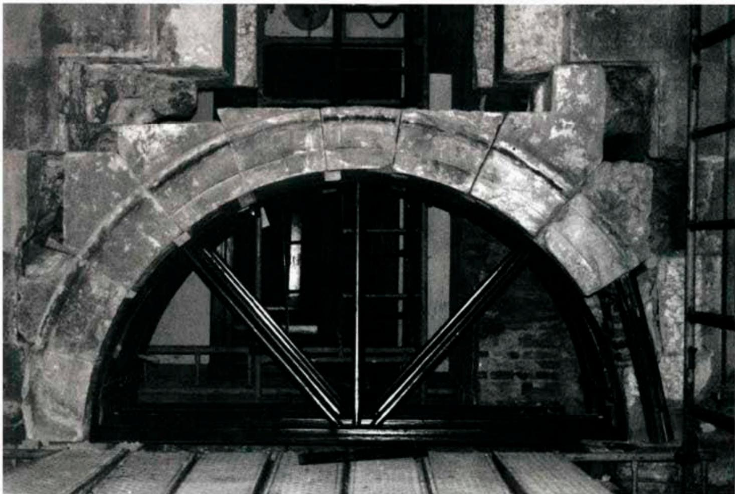
*Lám. 7. Vista frontal y detalle de cimbra para el montaje del arco.
