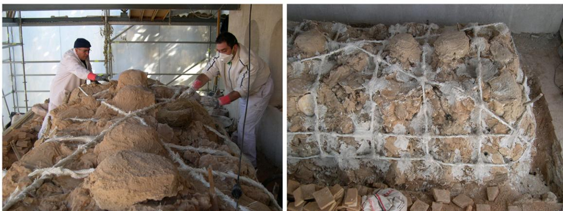
Il. 15. Proceso de restauración mediante la colocación de una malla de fibra de vidrio fijada mediante puntos de esparto amasado con escayola, en el reverso de la cúpula nº 7. Ramón Rubio Domene, sin título, 2008, Patronato de la Alhambra y Generalife, Archivo.
