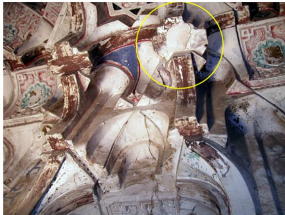
Il. 11. Pedro Salmerón Escobar, 2007, fotografía. Fisuras de las bóvedas de mocárabes y afloramiento de una perforación hacia el interior a causa de los elementos de sujeción colocados en 1857 (señalado con un círculo de color amarillo).
