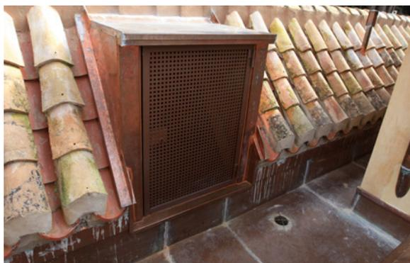
Il. 22. Pedro Salmerón Escobar, 2011, fotografía. Acabados de chapa de cobre en canales principales y tronera de acceso a las cubiertas para mantenimiento. Se observa al fondo un aspirador estático en chapa de cobre.
