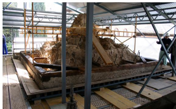
Il. 8. Pedro Salmerón Escobar, 2007, fotografía. Vista del trasdós de la bóveda de mocárabes M2. Trabajos de la intervención protegidos por la sobrecubierta colocada en todo el ámbito de la Sala de los Reyes.
