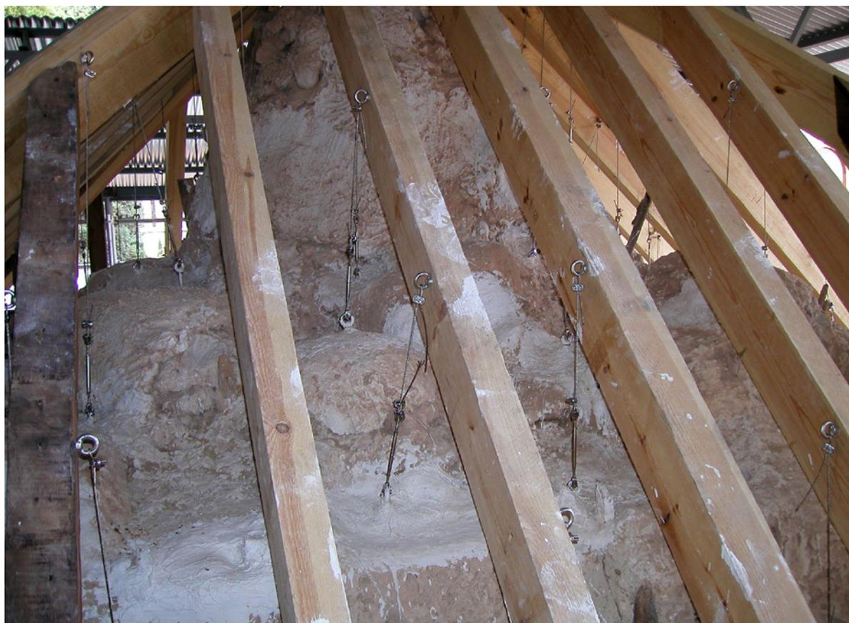
Il. 16. Pedro Salmerón Escobar, 2007, fotografía. Tensores colocados en la nueva armadura de madera para sujeción elástica de la bóveda de mocárabes M2.
