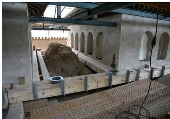
Il. 21. Pedro Salmerón Escobar, 2010, fotografía. Viga doble de madera laminada encolada para apoyo de la canal maestra y de la estructura. Posicionamiento de sumideros en PVC. Se puede observar el trasdós de la bóveda de mocárabes M5 entre los pabellones principales M4 y M6.
