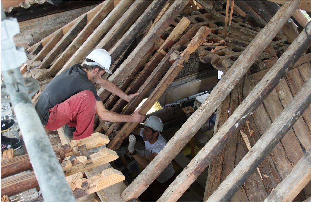
Il. 7. Artyco. Proceso de montaje de faldón de la armadura apeinazada. *Memoria de intervención Cubierta Oratorio del Partal y Casa de Astasio de Bracamonte (2015)*. APAG.
